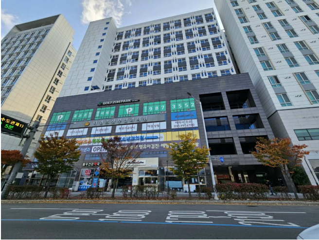
[본건 전경] 본건 북측에서 촬영
