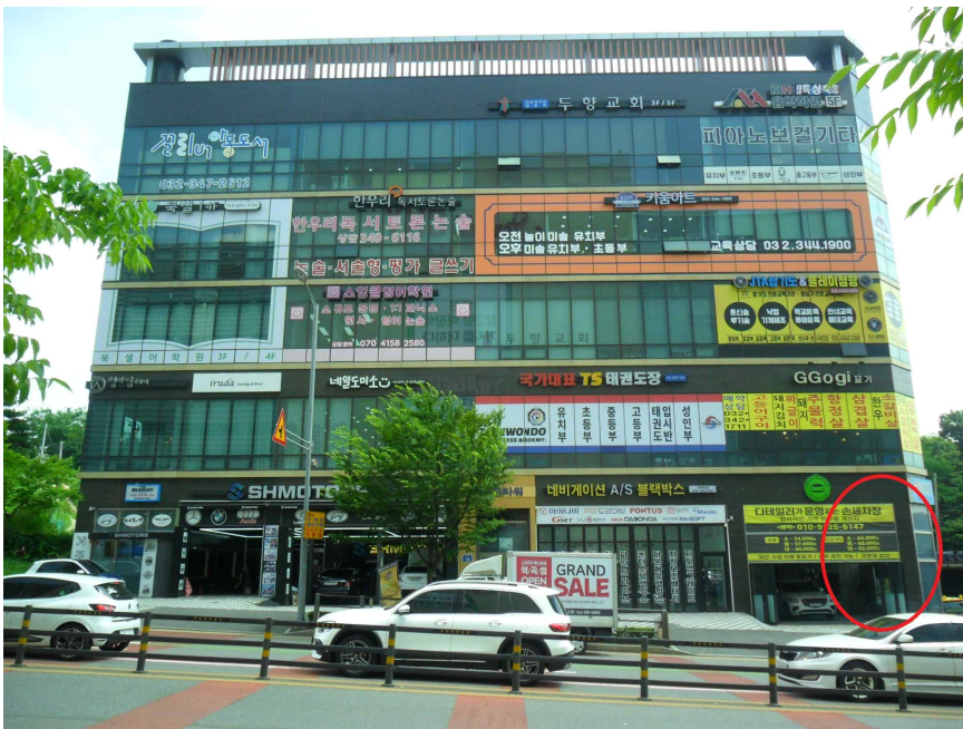
대상물건 소재 건물
