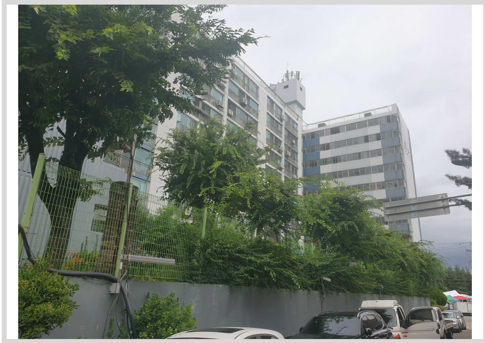
건물 남서측 전경
