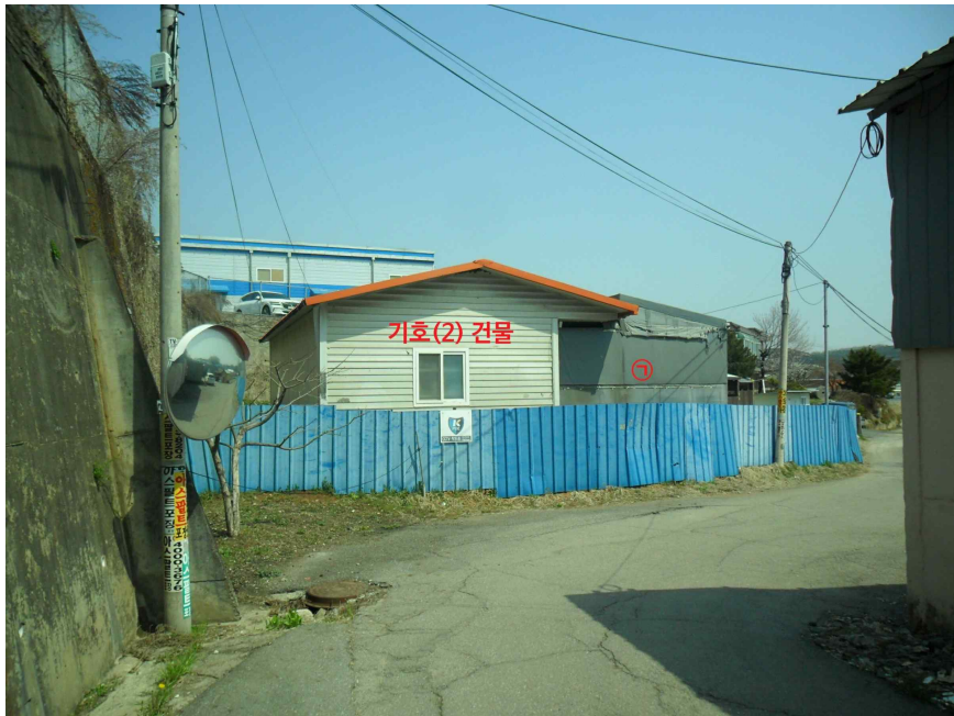
대상물건 전경 (남서측에서 촬영)
