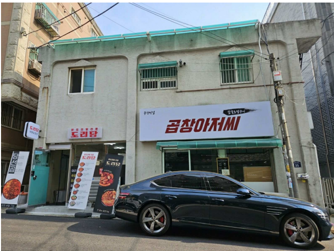
[본건 전경] 본건 북측에서 촬영
