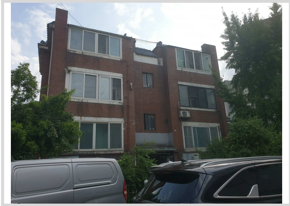
건물 북측 전경
