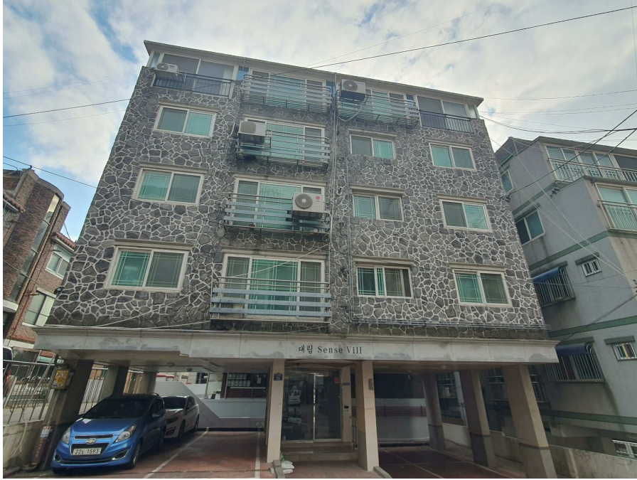
본건소재 건물 전경
