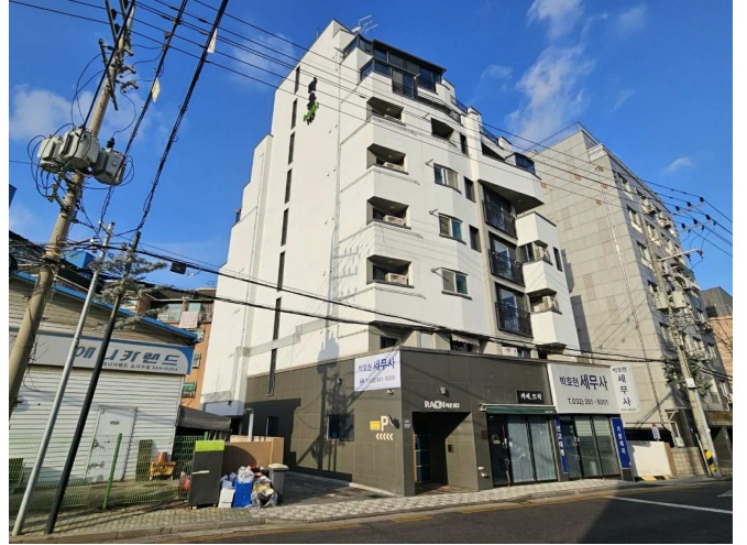
[본건 전경] 본건 남서측에서 촬영
