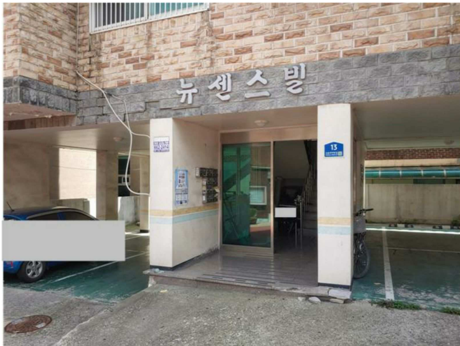
1층 공용출입구 전경
