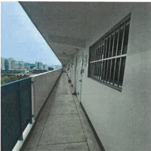
12층 복도 전경
