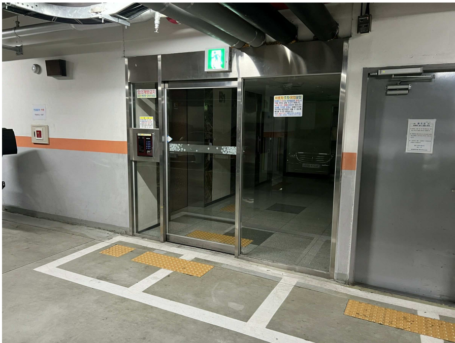
지하주차장 출입부 부분
