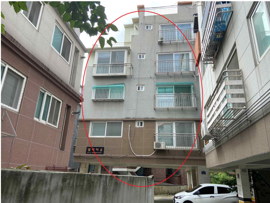
대상물건 소재 건물 (동측에서 촬영)
