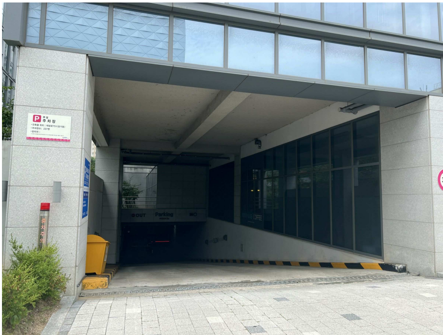
지하주차장 진출입부 부분
