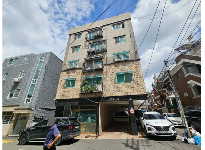
[본건 전경] 본건 남측에서 촬영
