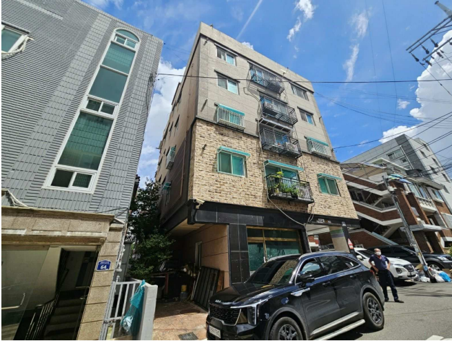
[본건 전경] 본건 남서측에서 촬영
