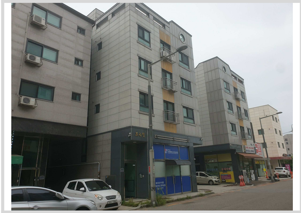
건물 남서측 전경
