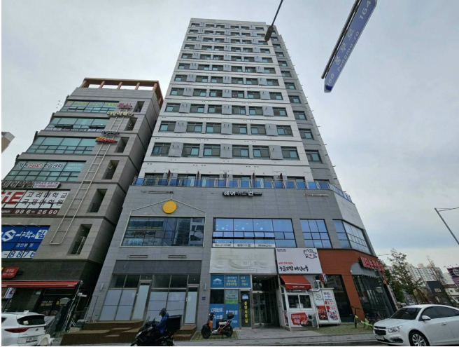
[본건 전경] 본건 북측에서 촬영
