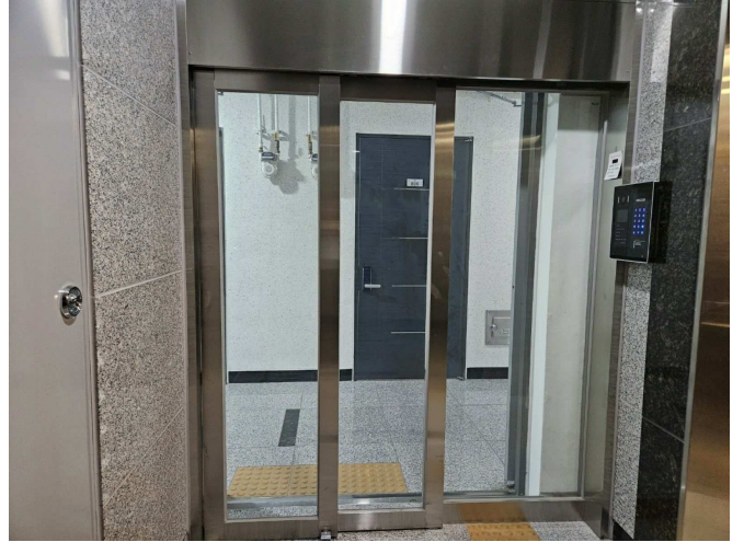
[본건 8층 출입구]
