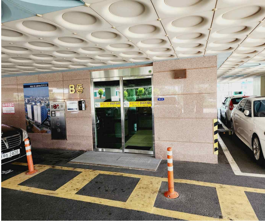
본건 1층 공동 출입구 전경
