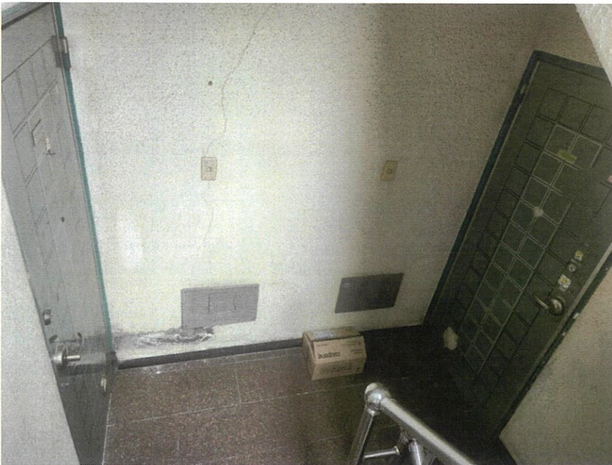
본건 4층 501호 현관문(현황 501호,502호)
