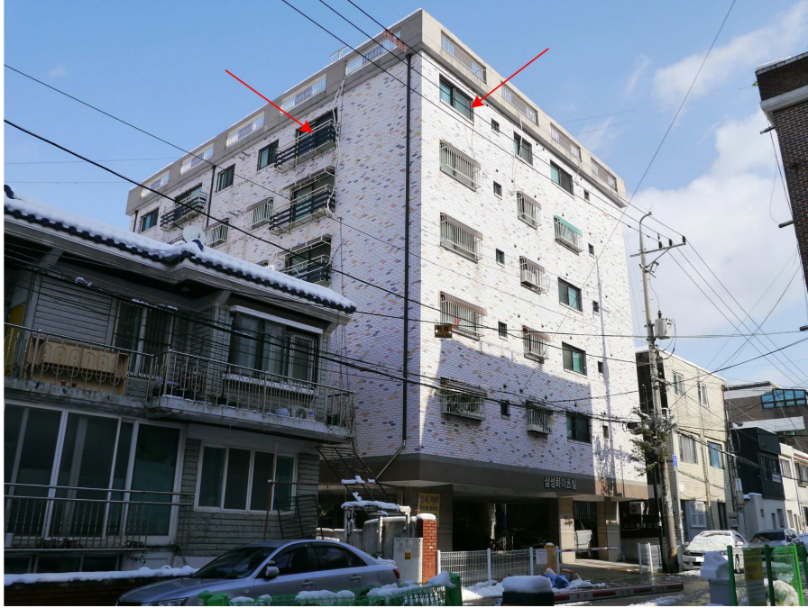
본건(삼성하이츠빌 6층 601호) 전경(남서측에서 촬영)
