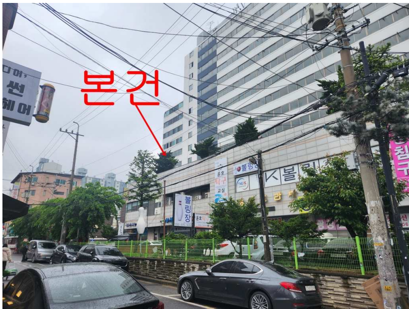
본건(광성상가 및 아파트) 전경
