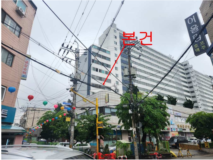
본건(광성상가 및 아파트) 전경
