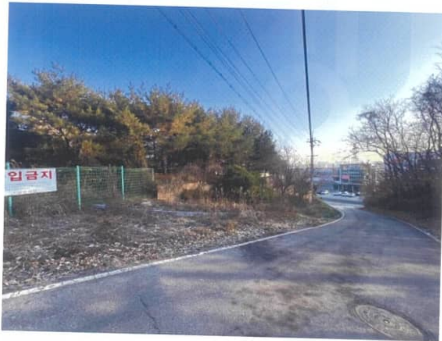
본건 접면도로 전경1
