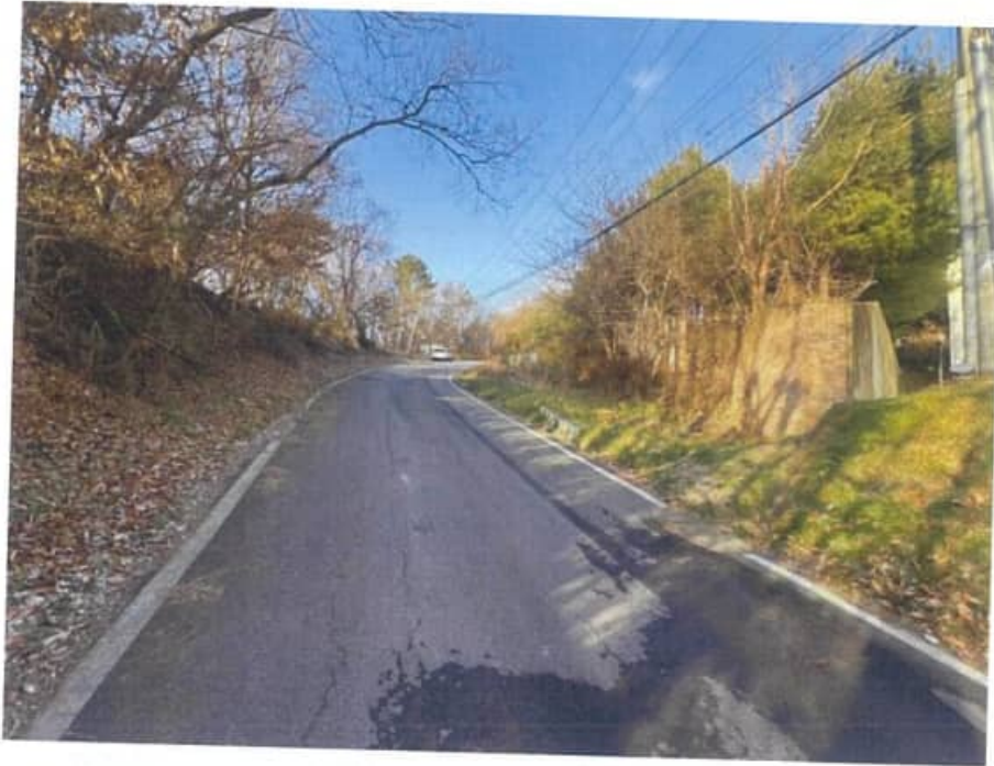
본건 접면도로 전경2
