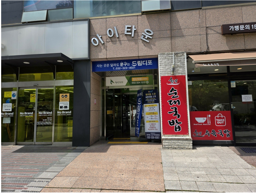
1층 출입구 전경
