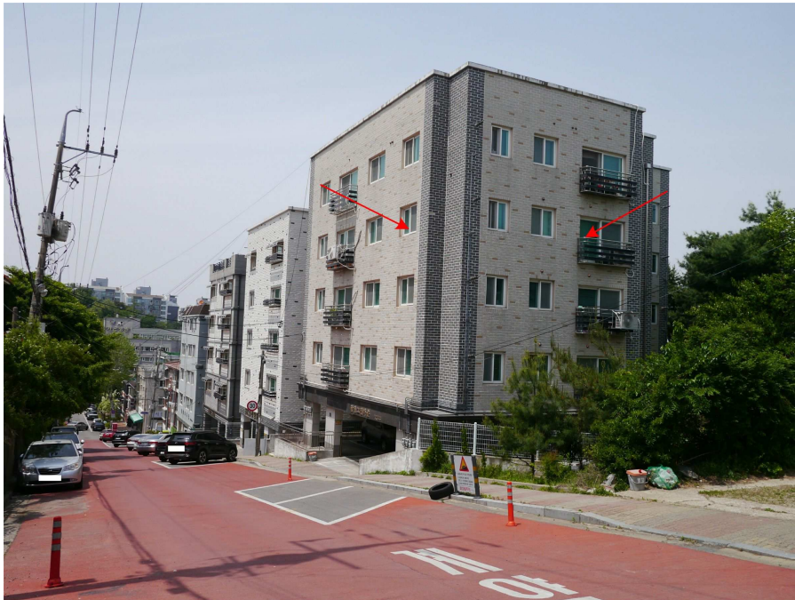
본건 및 주변모습(남동측에서 촬영)
