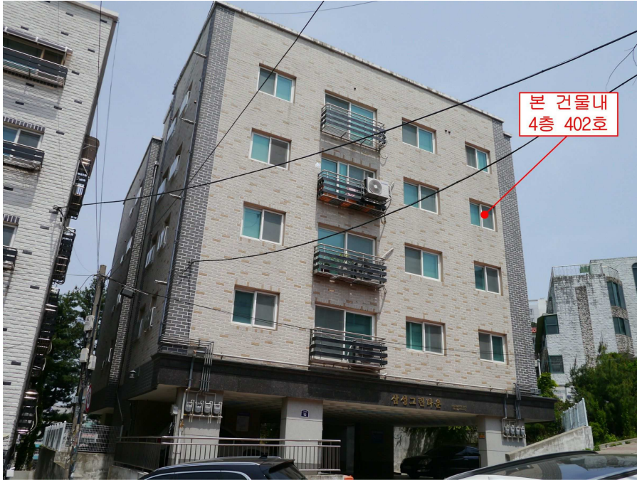
본건(삼성그린타운 4층 402호) 모습(남서측에서 촬영)
