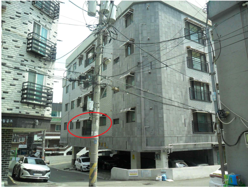
대상물건 전경 (남서측에서 촬영)
