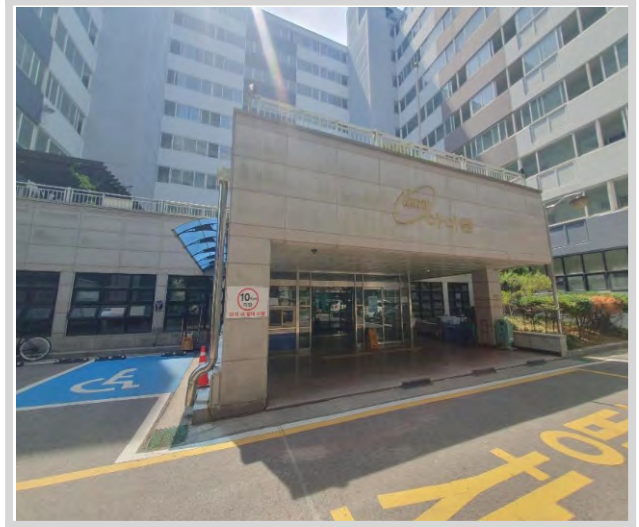
본건 출입구 전경
