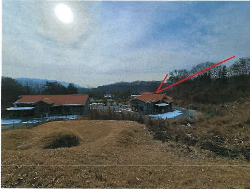
본건전경 및 주위전경
