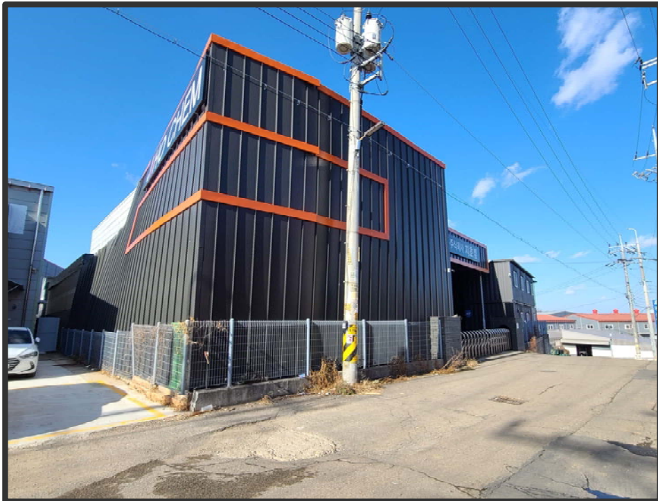
본건 전경 - 본건 남동측에서 촬영
