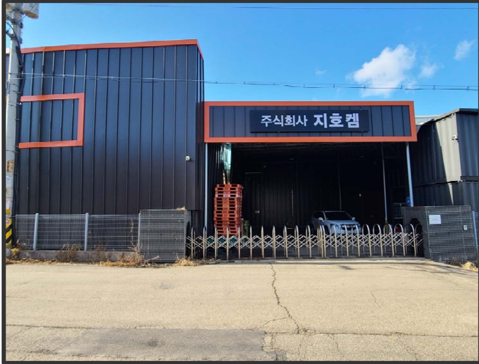
본건 전경 - 본건 동측에서 촬영
