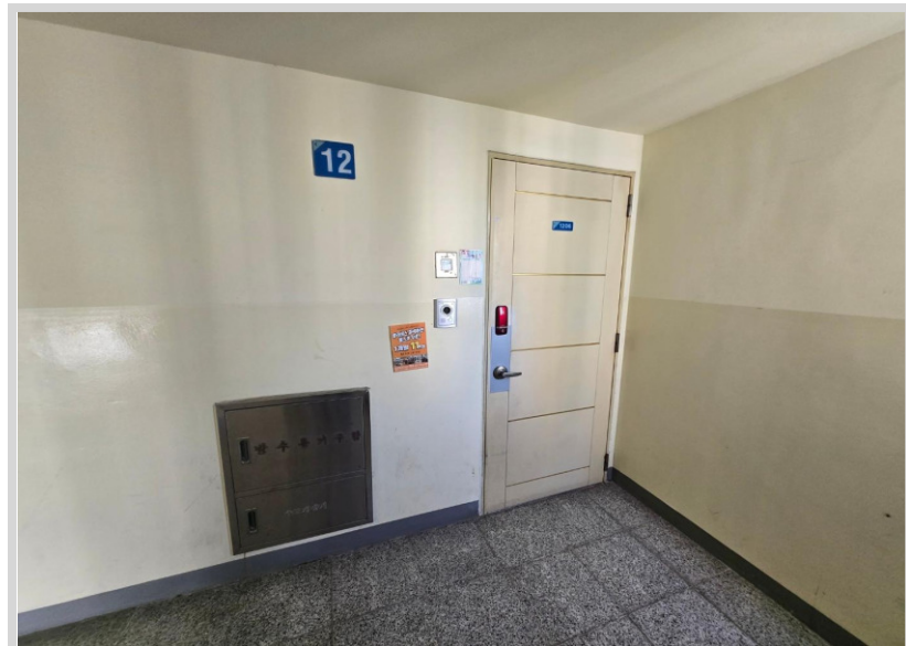
본건 내부현관 전경
