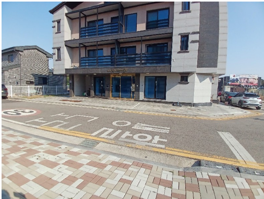
【본건 일련번호(1) 전경】
