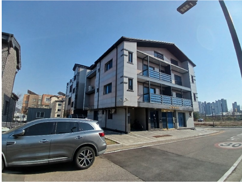
【본건 일련번호(2) 전경】
