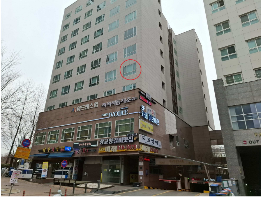
본건 전경(1) - 북서측 촬영
