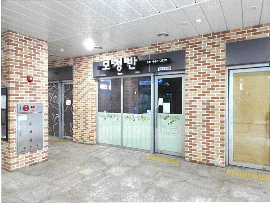
(일련번호 나)본건 전경
