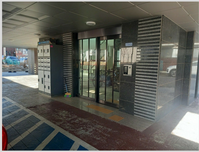
본건동 주 출입구 전경
