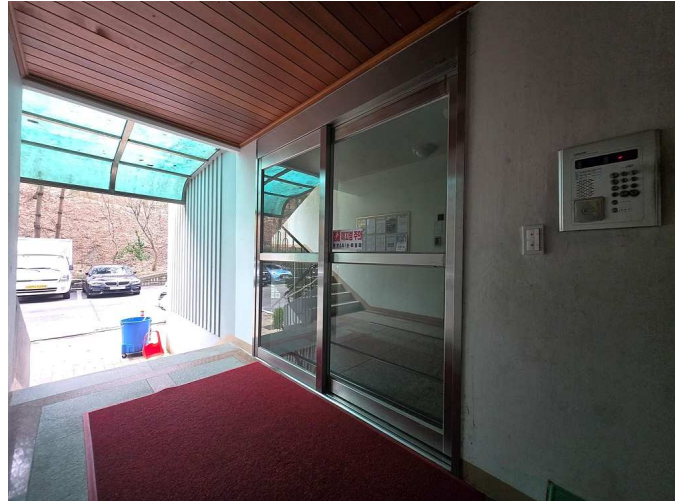
본건 공동 출입구(2)
