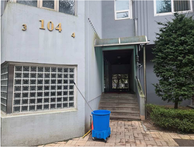
본건 공동 출입구(1)
