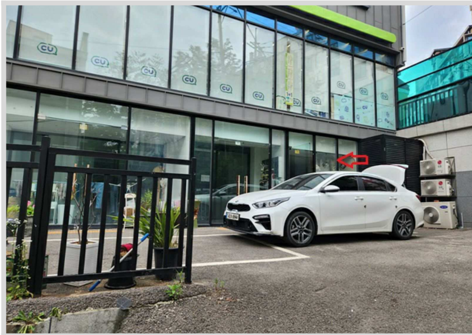
1층 근린생활시설 부분
