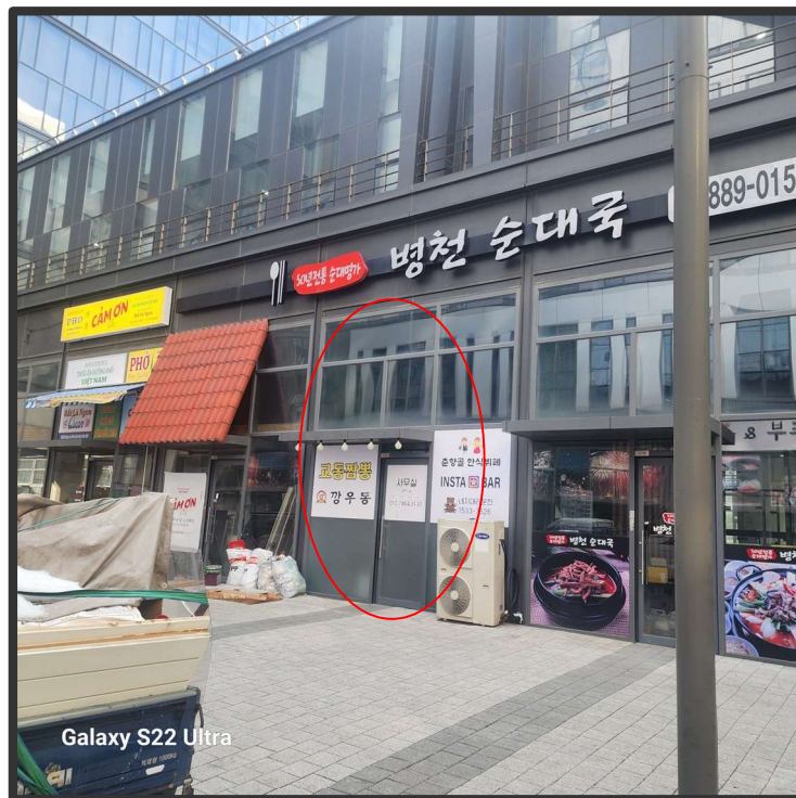
1층 L137호 전면부 촬영
