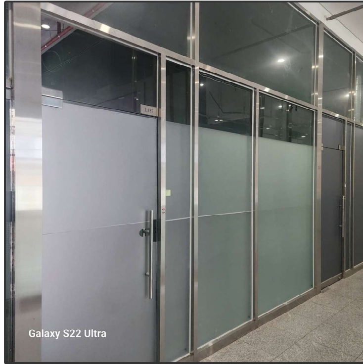
1층 L137호 내부 복도 촬영
