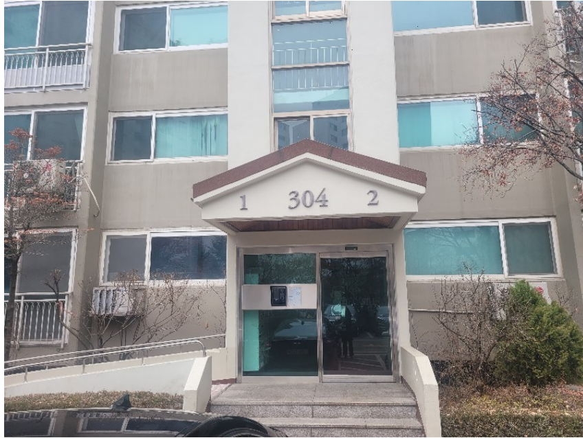
【본건 출입구 전경】
