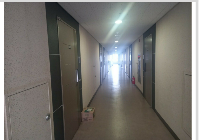
본건 11층 복도 전경
