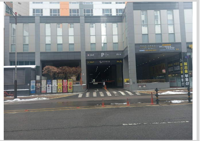
본건동 주차장 출입구 전경
