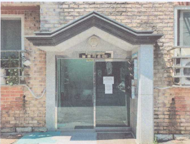
본건 기호(가) 소재 건물 공동현관 전경
