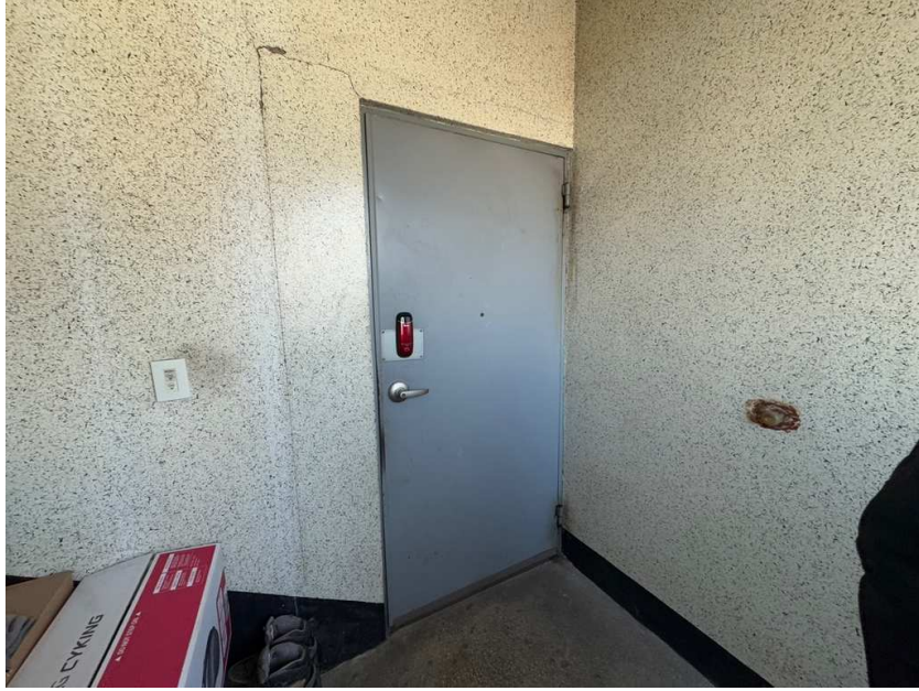
[ 일련번호 2) 2층 출입구전경 ]
