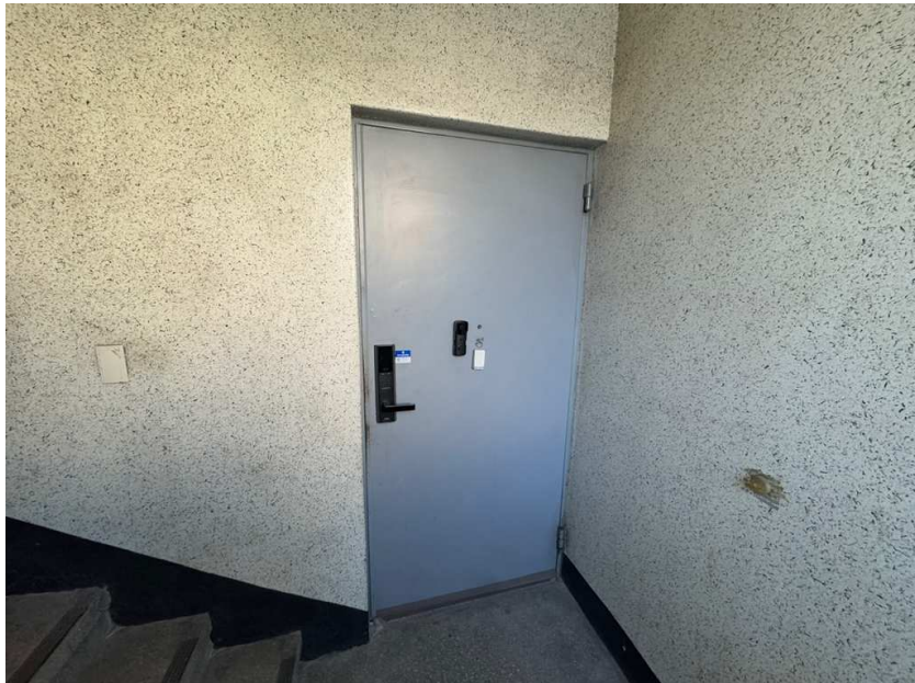
[ 일련번호 2) 3층 출입구전경 ]
