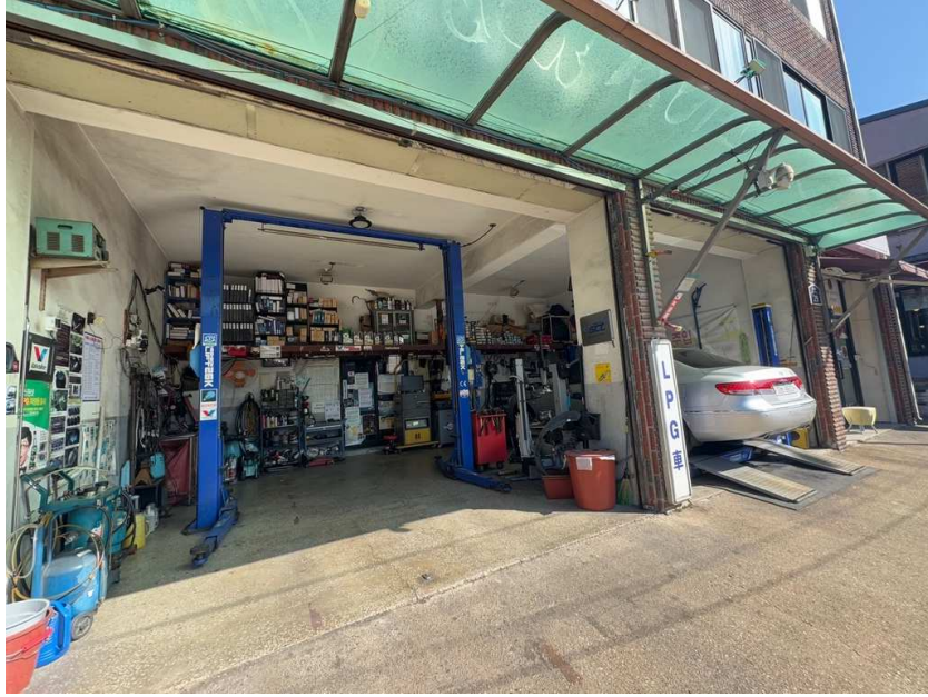
[ 일련번호 2) 1층 전경 ]
