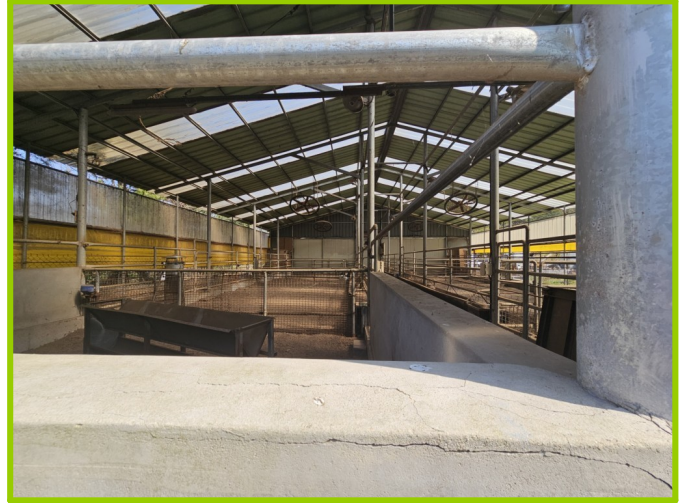
일련번호(2) 및 제시외 건물(ㄱ,ㄴ) 내부
