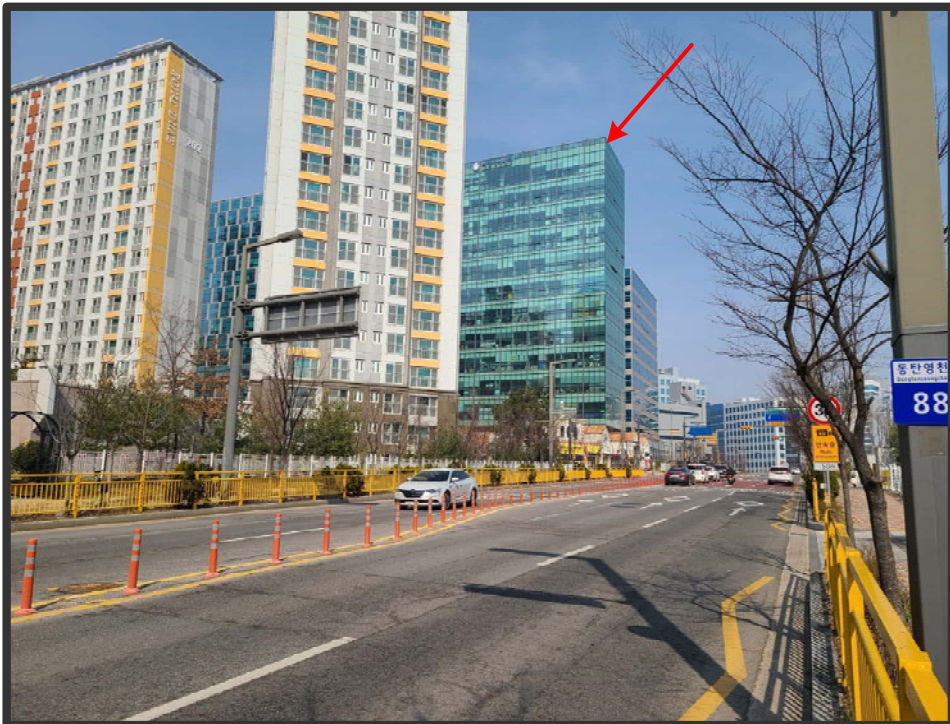
주위환경 - 본 건물 남동측에서 촬영
