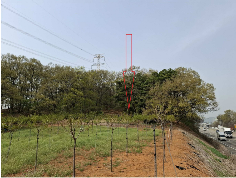
본건 전경(1) - 남측 촬영
