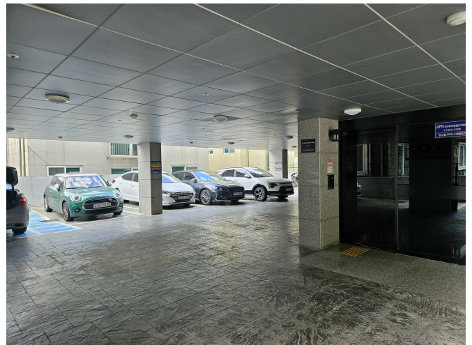
본건 1층 주차장
