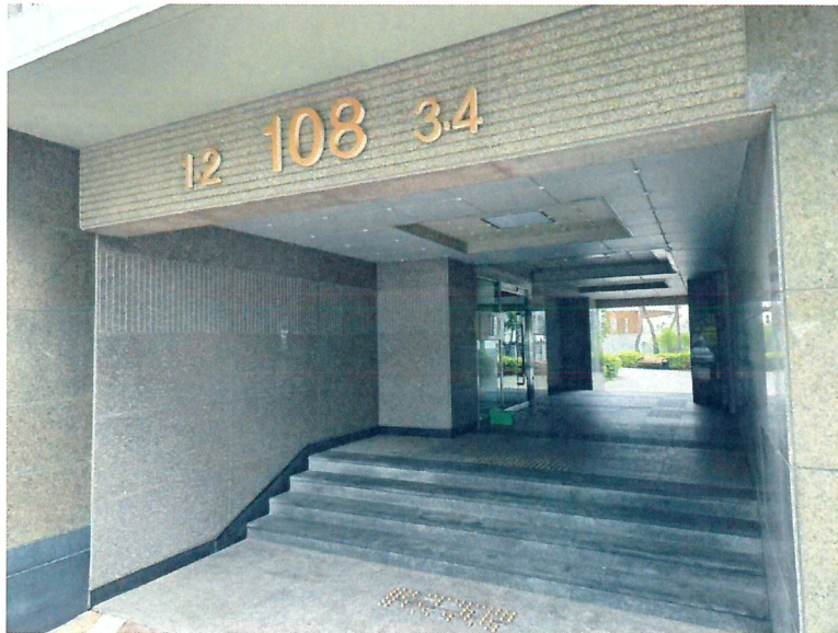
< 본건 1층 출입문 >
