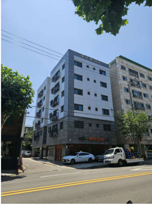
대상물건 소재 건물
