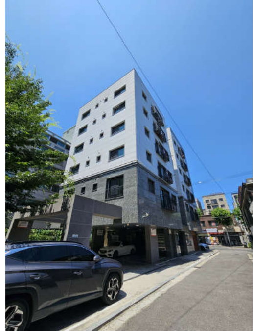
대상물건 소재 건물
