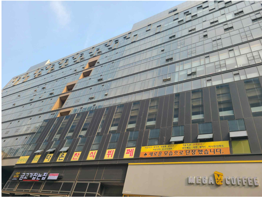
본건 구분건물 외부 전경
