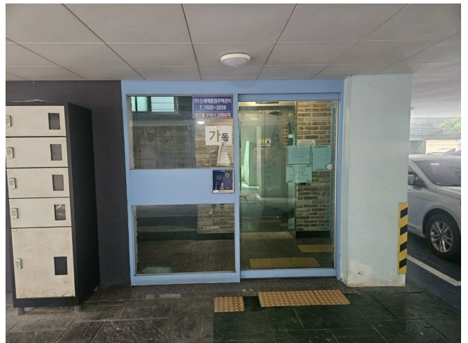
기호(가) 공동 출입문 전경
