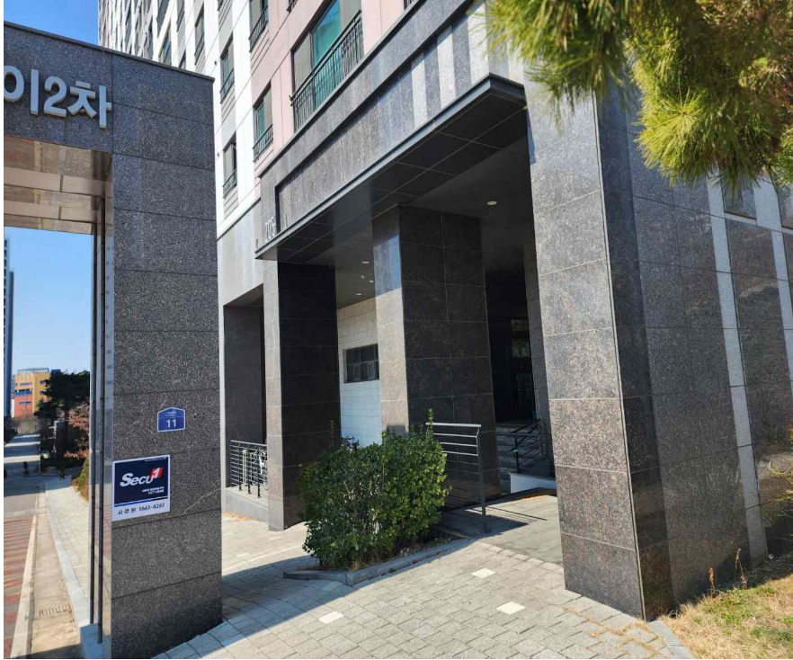
본건동 1층 공동 출입구 전경1
