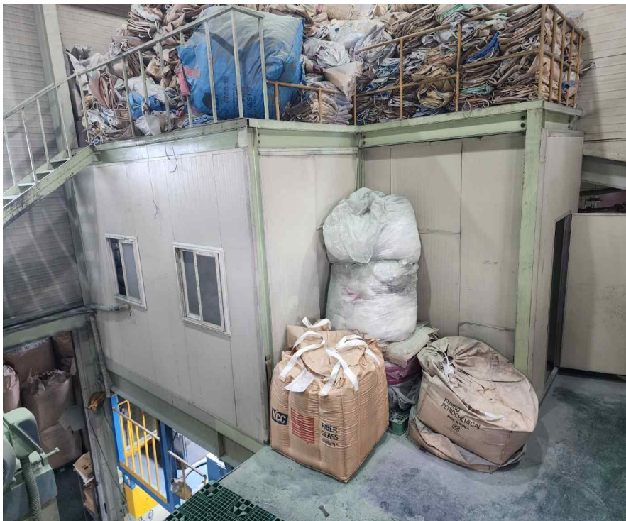
건물 남측 중2층 소재 판넬조 판넬지붕 창고-건물에 포함평가
