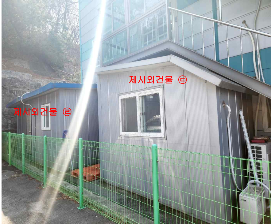
제시외건물 ㉔, ㉔ 전경
