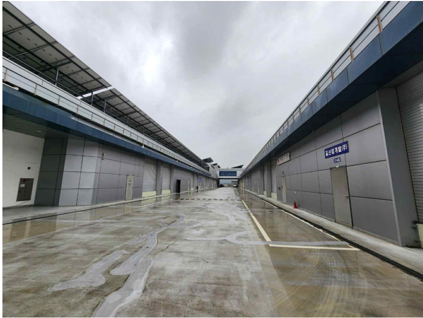
본건 3층 전경
